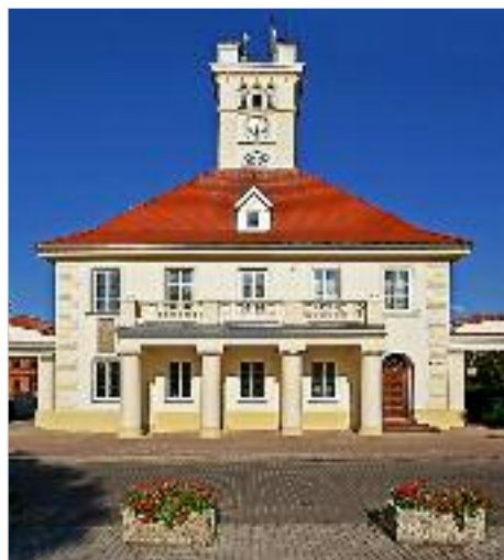
♦ Bloniu – restauracja elewacji zabytkowego Ratusza, ul. Rynek 6 – Urząd Miejski w Bloniu
