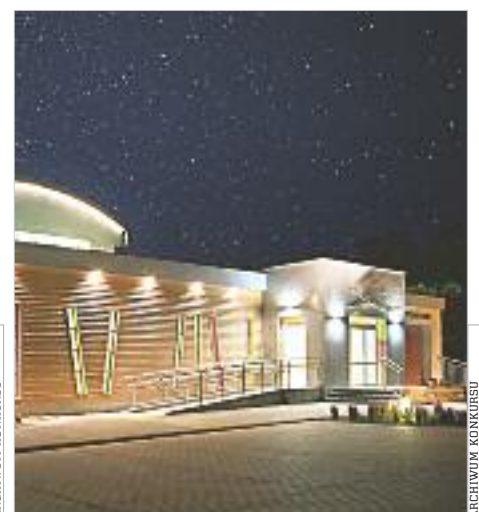
➤ Wszehświętę, gm. Oleśnica – modernizacja i rozbudowa szkoły – ARCHIGRA, Oleśnica
