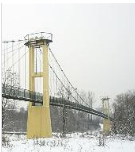
♦ Damienice – modernizacja kładki nad rzeką Rabą – Gmina Bochnia
