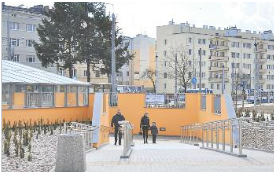
♦ Zmodernizowany węzeł w Gdyni zapewnia bezpieczeństwo wszystkim użytkownikom drogi
