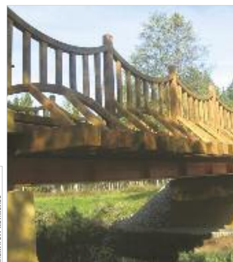
♦ Poczopok – modernizacja drogi z mostem na rzece Starzyńce – Nadleśnictwo Krynki
