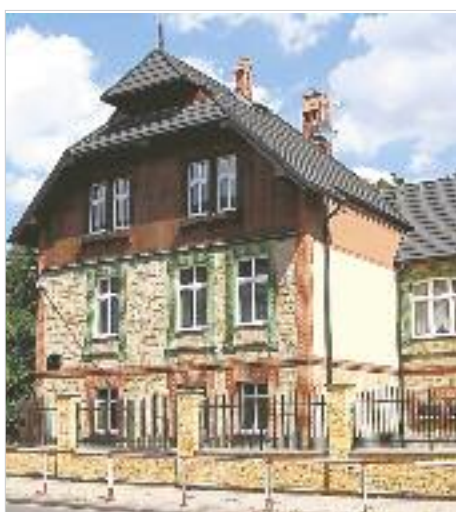
♦ Chorzów – remont elewacji budynku, ul. Katowicka 46 – Zakład Komunalny PGM Chorzów
