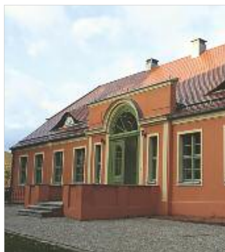
➤ Wolin – restauracja zabytkowego dworu, ul. Zamkowa – Gmina Wolin
